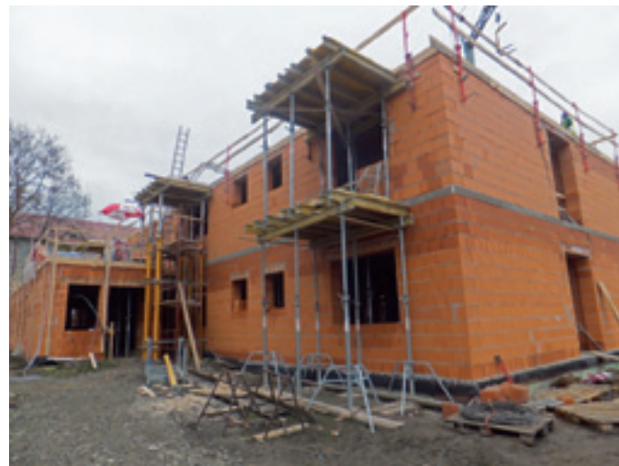
stavba Domova dôchodcov a domu sociálnych služieb Senior
