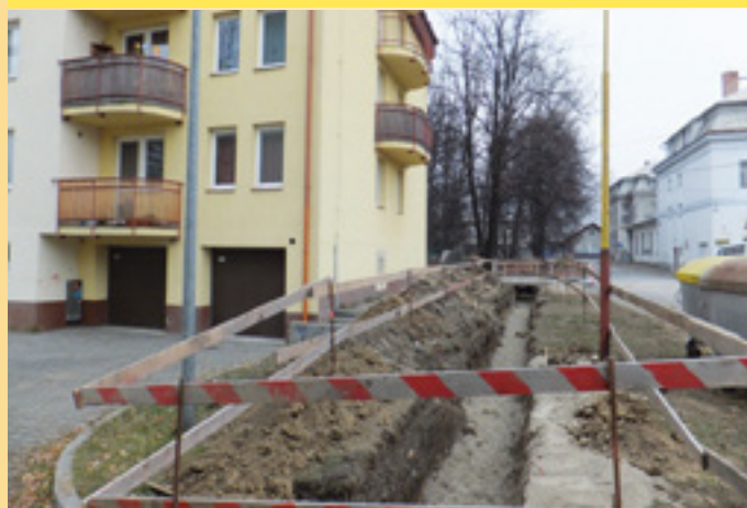
výkopové práce v ulici vedľa bytovky
