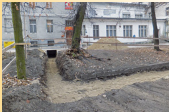
výkopové práce pred budovou Kina 1. máj, sústava CZT sa napojí do priestorov kotolne v suteréne
