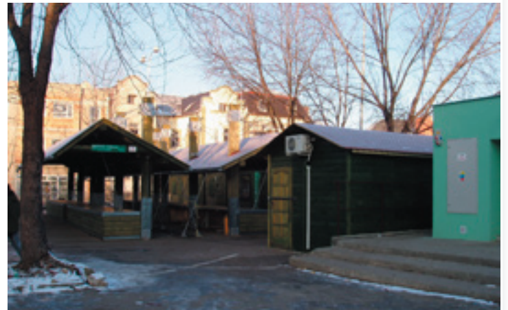
Nová tržnica, vpravo zrekonštruované verejné WC, vzadu zrekonštruovaná budova bývalého hotela Magura
