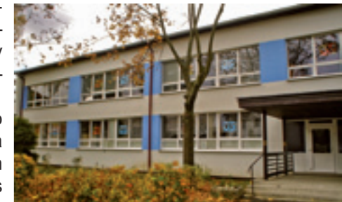
Rekonštrukcia školy na Ul. M. R. Štefánika
