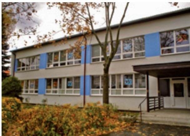
Súčasný stav budovy našej 35 ročnej školy
