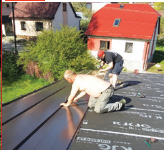
Výmena strešnej krytiny na mestskom kúpalisku
