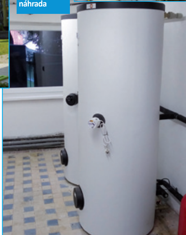
Zásobník na ohrev vody na futbalovom štadióne pred výmenou a jeho nová náhrada
