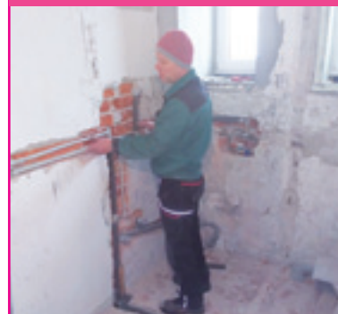
Rekonštrukcia byt. priestorov po bývalej ADOSke
