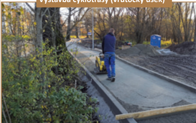
Výstavba cyklotrasy (vrútocký úsek)
