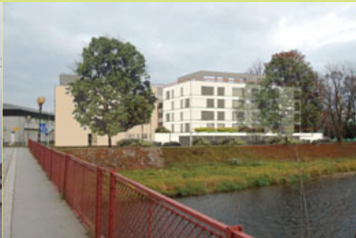
Nová, priestranná a zaujímavá budova tiež čaká...
