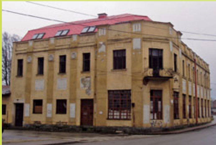
Stará, zničená a chátrajúca budova čaká...
