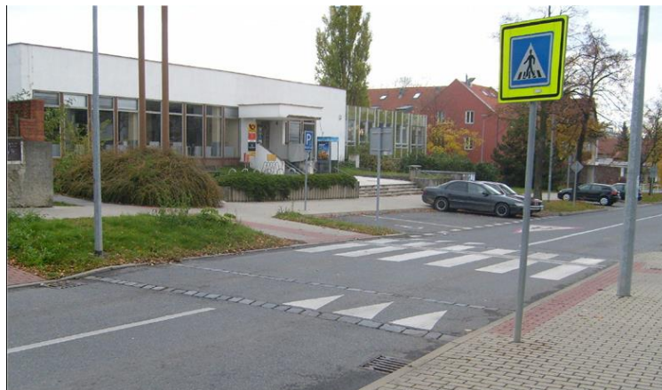
Obr. 6 Příklad dlouhého zpomalovacího prahu s integrovaným přechodem pro chodce
