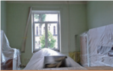
Výmena okien v budove MsÚ
