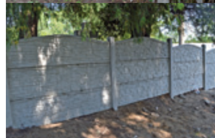
Plot na cintoríne pred a po rekonštrukcii
