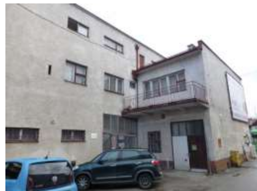
Požiarna zbrojnica (DHZ)
